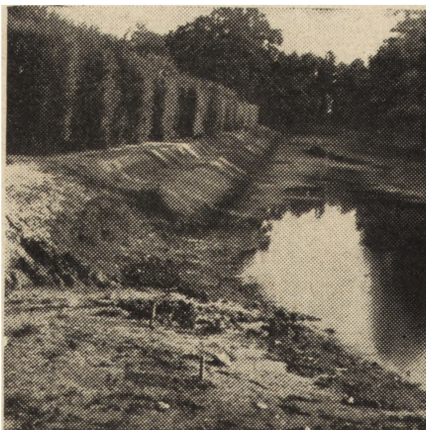
Ryc. 9. Nieborów, prace przy rekonstrukcji kanału (fot. G. Ciolek, 1948).
