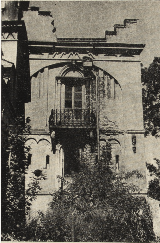
Ryc. 284. Zamek w Radziejowicach — elewacja południowa, 1956.
