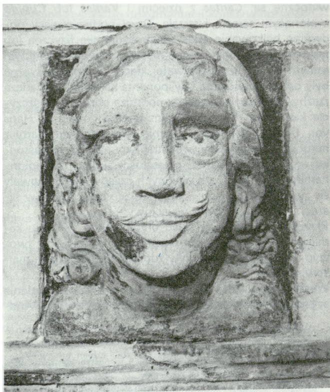
7B. Fasada kamienicy przy ul. Piwnej 1 w Gdańsku. Rzeźba w trakcie konserwacji 7B. The facade of the house at 1 Piwna Street in Gdańsk. A sculpture during conservation.
