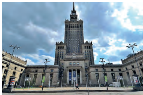
Ryc. 5. Pałac Młodzieży w Warszawie, stan obecny
