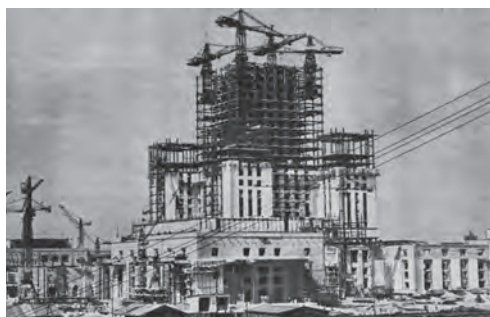
Ryc. 1. Budowa Pałacu Kultury, stan w 1953 r.
