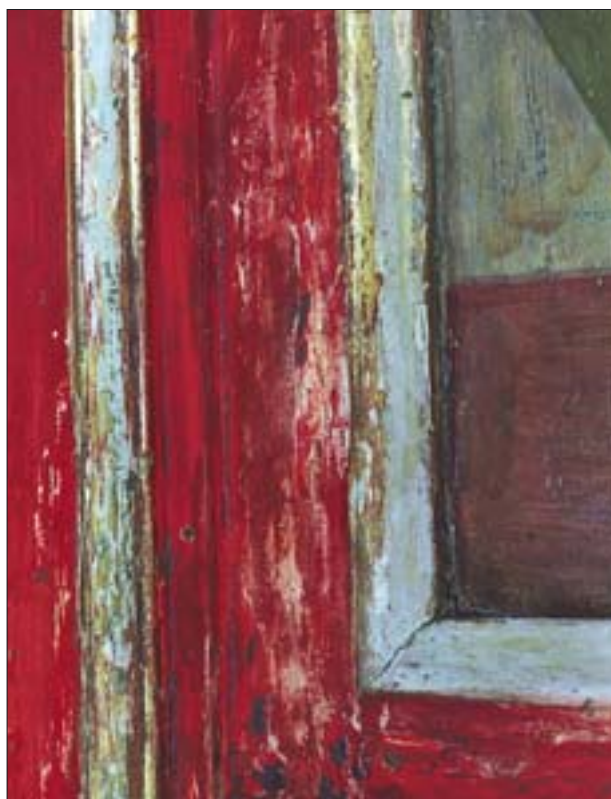
23. Fragment bordiury malowidła z przedstawieniem św. Jadwigi w trakcie usuwania wtórnych warstw przemalowań.
