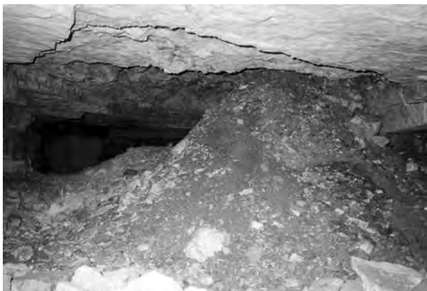
1. Spękania odpowierzchniowe niszczą stropy wyrobisk neolitycznych, grożąc zawaleniem podziemi. Wszystkie fot. W. Borkowski
