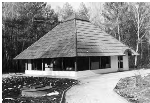
6. Pawilon trasy turystycznej nr 1 otoczony opaską odwadniającą
