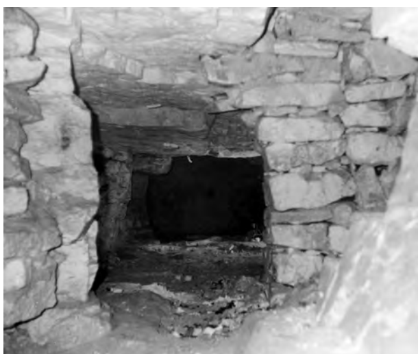
2. Zabezpieczenia wyrobisk z lat pięćdziesiątych poddają się z czasem działaniu procesów wietrzeniowych
