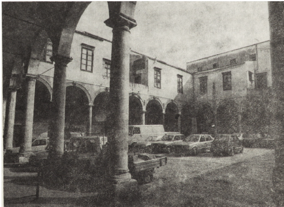
4. Palermo, dawny klasztor Św. Anny; wyraźna degradacja i niewłaściwe użytkowanie
