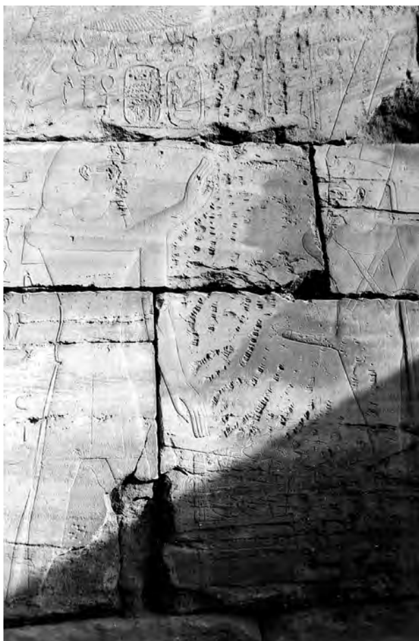
9. Uszkodzone przez obrostkę ( Chalicodoma siculum Risso) ściany z piaskowca pokryte płaskorzeźbami (świątynia w Luksorze) 9. Sandstone walls covered with bas-relief, damaged by the Chalicodoma siculum (Risso) (temple in Luxor)
