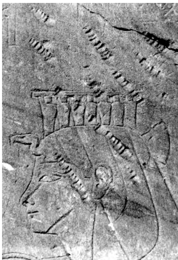
9. Uszkodzone przez obrostkę ( Chalicodoma siculum Risso) ściany z piaskowca pokryte płaskorzeźbami (świątynia w Luksorze) 9. Sandstone walls covered with bas-relief, damaged by the Chalicodoma siculum (Risso) (temple in Luxor)
