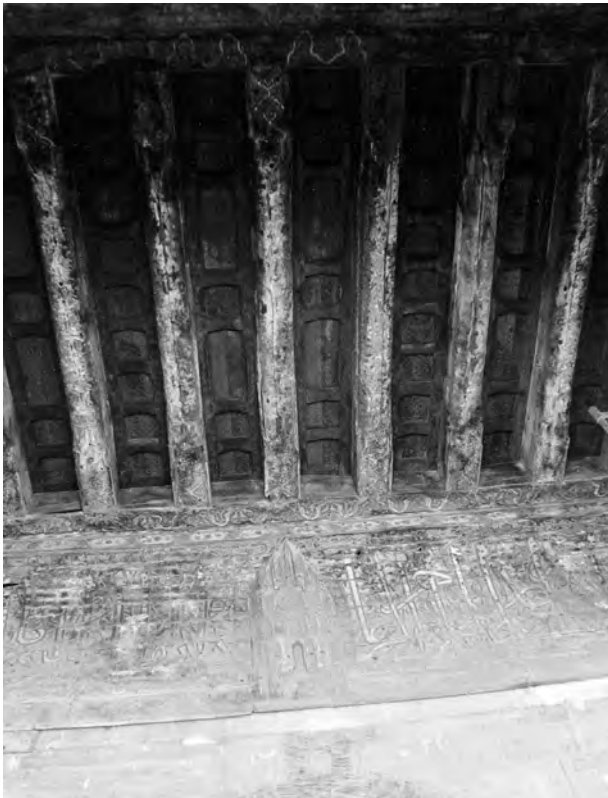
4. Fragment części stropu z pocz. XVI w. nad północnym liwanem madrasy meczetu emira Kebira Kurkumasa w Kairze z oryginalnymi belkami z kłódzin palmy daktylowej (stan w lutym 1996 r.), chętnie zasiedlanymi przez zadrzechnię ( Xylocopa aestuans L.)
