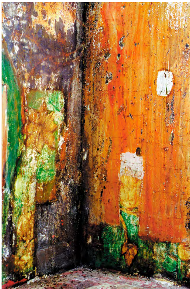
4. Prawy narożnik wnęki po demontażu wyposażenia i wykonaniu odkrywek — fragmenty wici kwiatowej na laserowanym na zielono tle i utóme srebrzenie z oranżowym laserunkiem. Fot. W. Grzesik
