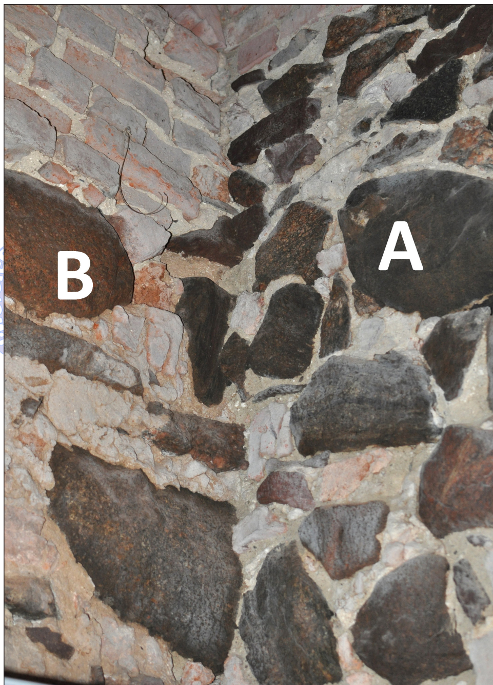
Ryc. 9. Południowa ściana skrzydła północnego w kondygnacji piwnicznej (A) dostawiona na styk do wschodniej ściany obwodowej domu konwentu (B); fot. autor.
