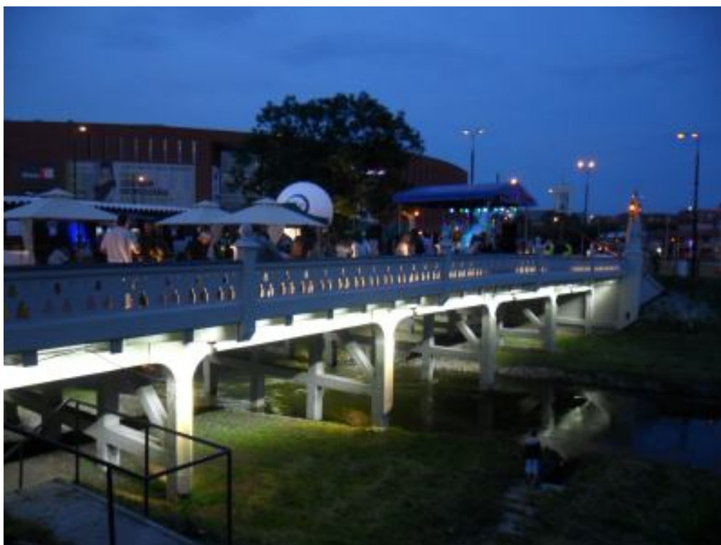
Ryc. 2. Most im. M. Lutosławskiego na Bystrzycy w Lublinie – Most Kultury (fot. S. Bernat)
