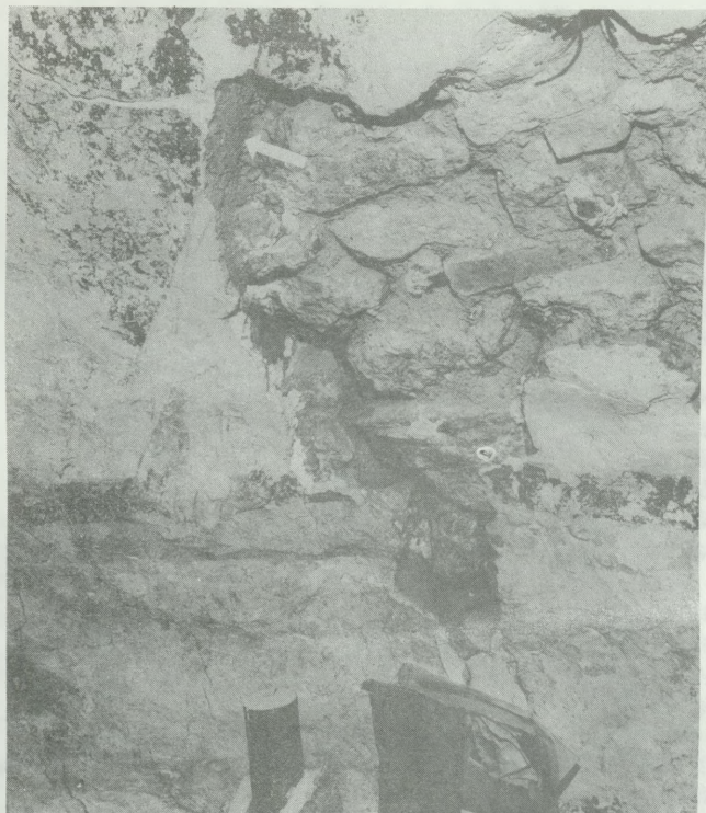
14. Środkowa część sklepienia absydy, widoczna pianka wypełniająca wnętrze pęcherza (fot. E. Kosakowski, 1985)
