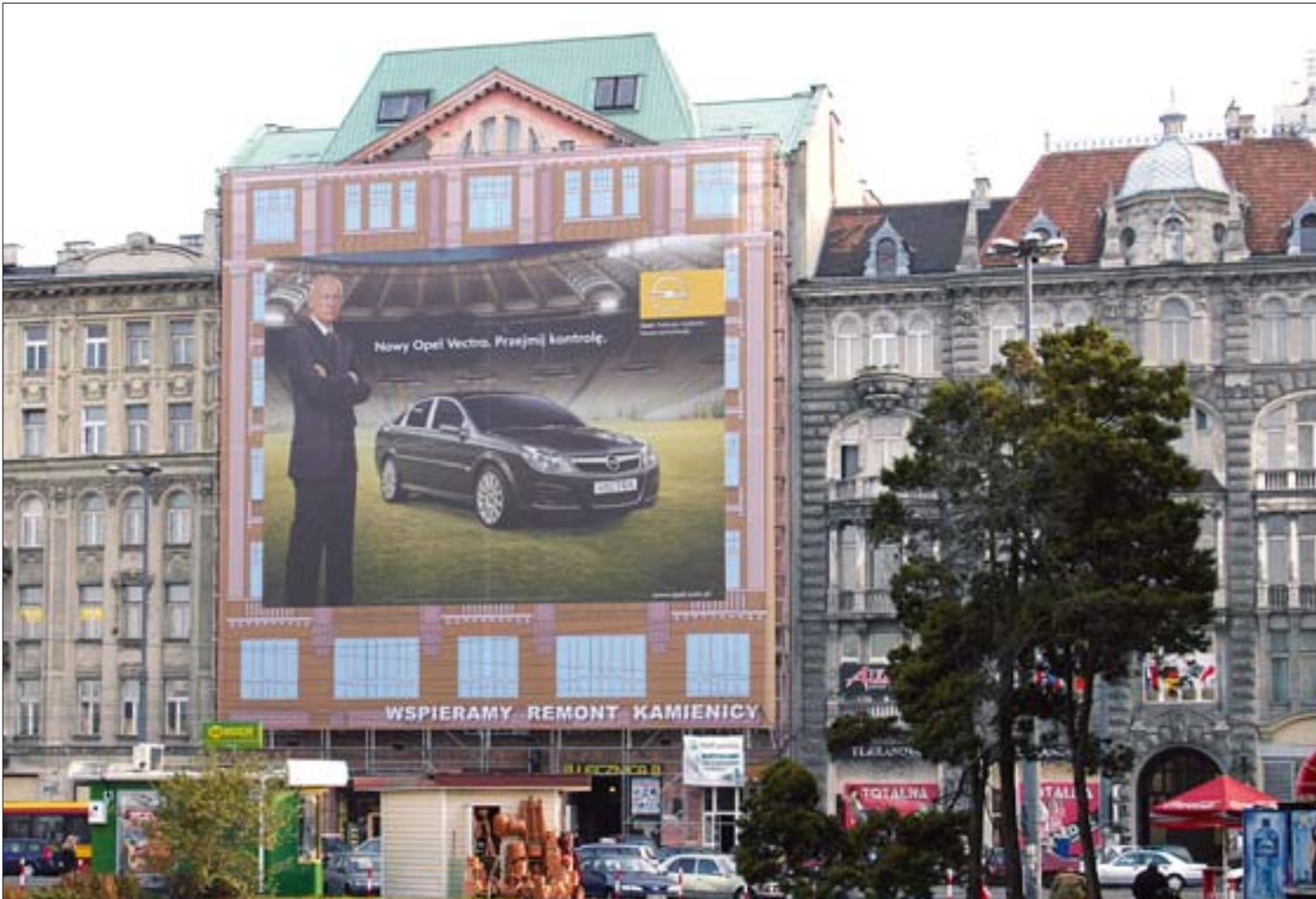
1. Warszawa, remontowana kamienica w Alejach Jerozolimskich. Fot. P. Kobek. 1. Warsaw, renovated building on Jerozolimskie Avenue. Photo: P. Kobek.
