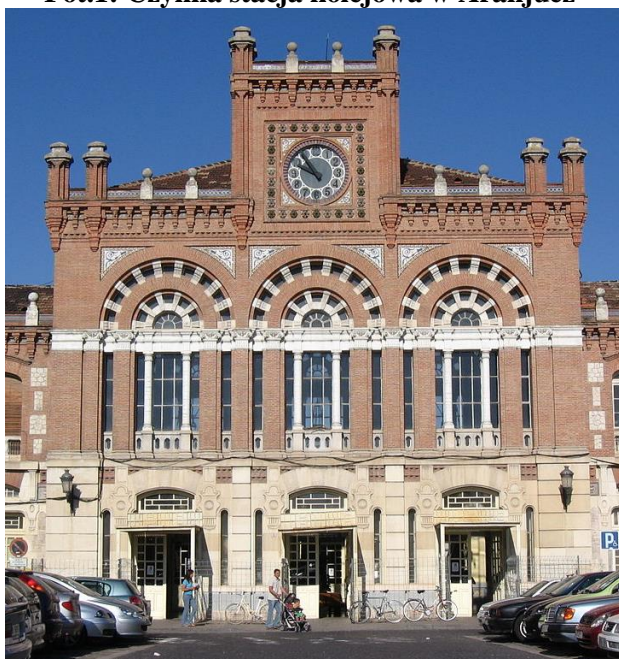
Fot.1: Czynna stacja kolejowa w Aranjuez
