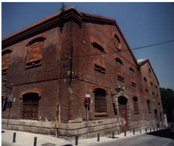
Fot.17: Budynek starej elektrowni.
