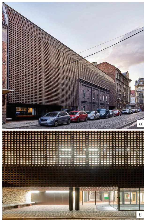
Il. 8. Siedziba Wydziału Radia i Telewizji Uniwersytetu Śląskiego w Katowicach (projekt: BAAS Arquitectura / Grupa 5 Architekci / MAŁECCY Biuro Projektowe, 2011–2014): a) elewacja północna przyległa do ulicy Św. Pawła, b) fragment elewacji północnej z widocznym detalem przykrywającej budynek ażurowej osłony ceramicznej i słupami o krzyżowym przekroju (fot. J. Certowicz)
