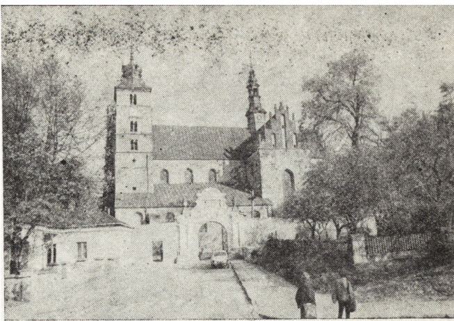
4. Opatów, kolegiata, w trakcie prac konserwatorskich (1987)
