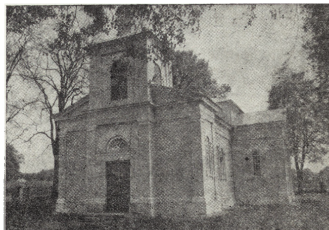
6. Otrocz, kościół parafialny p.w. Narodzenia NMP – stan po konserwacji (1987)
