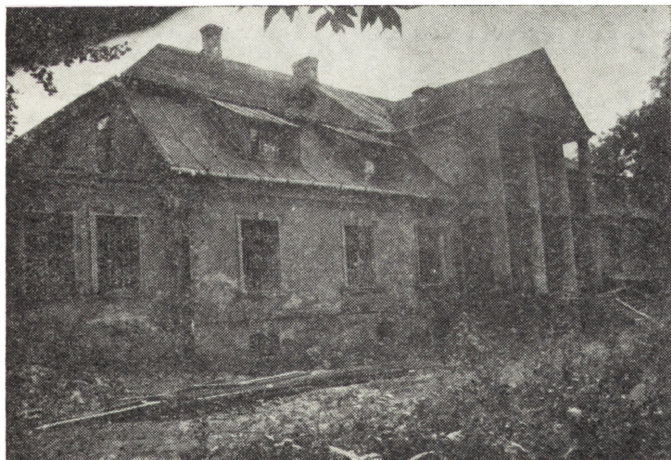
8. Zbydniów, dwór w trakcie prac konserwatorskich (1987)
