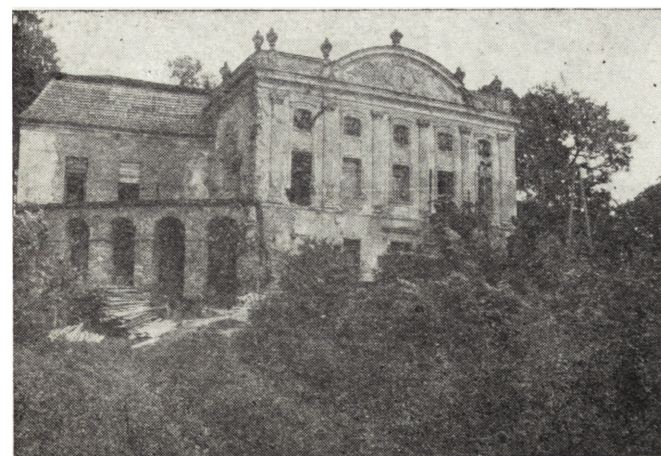
3. Kurozwęki, zamek w trakcie prac konserwatorskich (1985)
