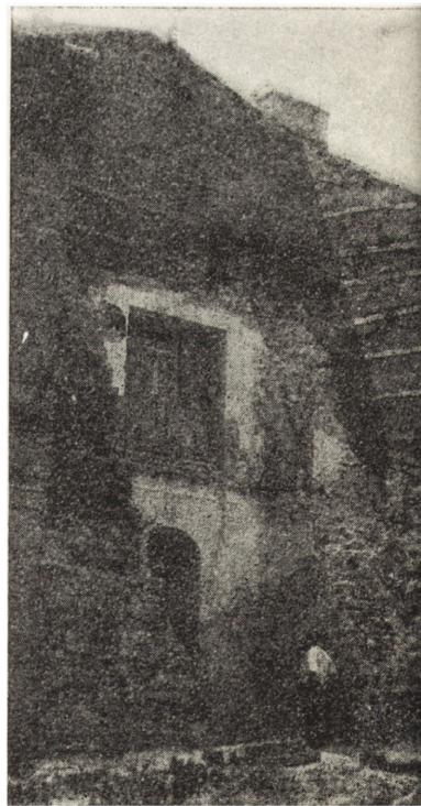
6. Wieluń, brama Krakowska XIV w., stan w czasie prac konserwatorskich w 1970 r. (fot. M. Pracuta)
