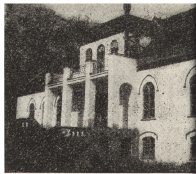
5. Ujazd, pow. Brzeziny, pałac neogotycki, stan po konserwacji 1972 r. (fot. M. Pracuta)
