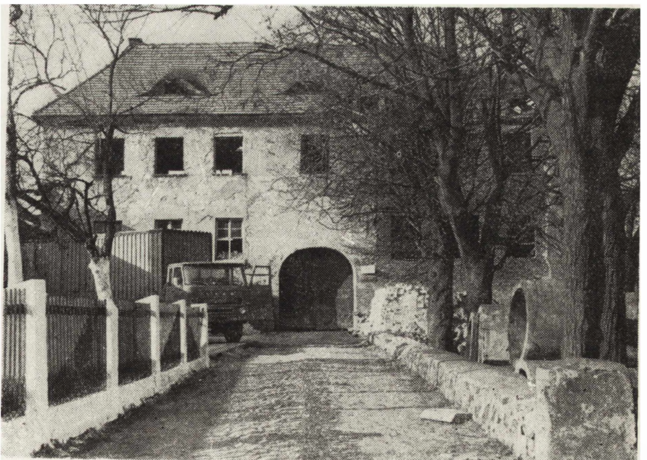
5. Połczyn-Zdrój, zamek w trakcie prac remontowo-konserwatorskich — 1978 r. (fot. D. Ptaszyńska)
