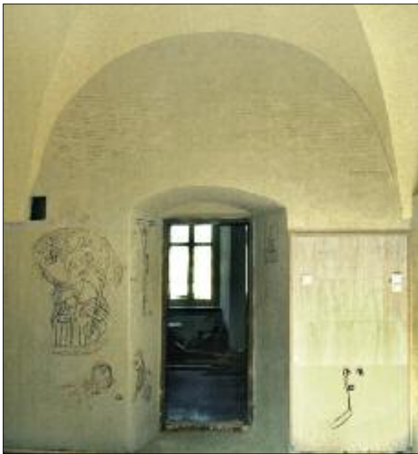
6. Cella nr 2, malowidła ściany wschodniej. 6. Cell no. 2, murals on the south wall.
