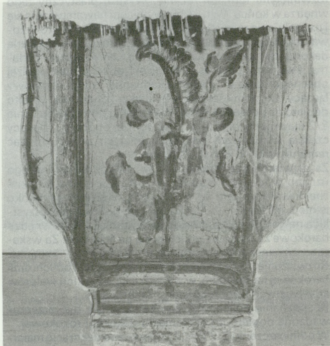
6. Pomieszczenie 2/3. W odkrywce widoczne fragmenty drewnianego stropu z 3 ćw. XVI w. oraz fragment jego rokokowej dekoracji malarskiej z końca XVIII w.
