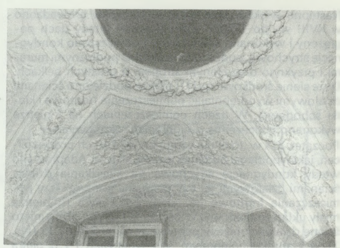
3. Pomieszczenie 2/1, fragment sklepienia. Widoczna dekoracja stiukowa wykonana przez Baltazara Fontanę w latach 1695–1702
