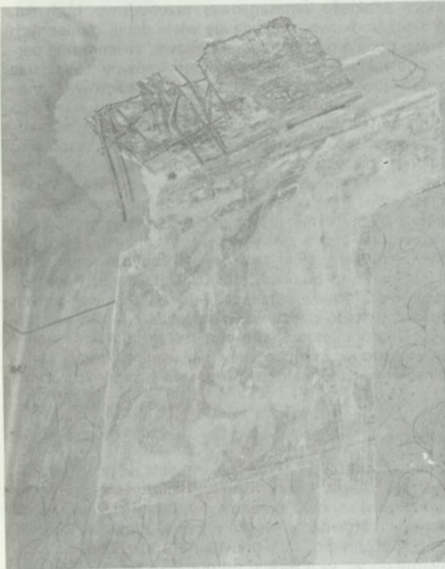
2. Pomieszczenie 2/11, ściana wschodnia. W odkrywce widoczny fragment barokowego malowanego fryzu podstropowego z końca XVII w.
