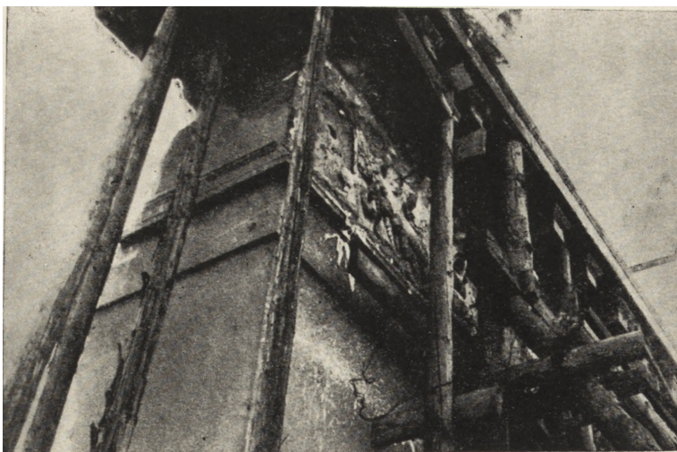
Ryc. 300. Teatr Wielki w Warszawie — elewacja frontowa i gzyms tympanonu.
