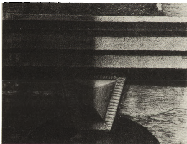
2. Fragment wieżyczki południowo-zachodniej Ratusza Staromiejskiego w Toruniu. Część kamieniarki oczyszczona roztworem kwasu fluorowodorowego (Fot. J. Wolski)
