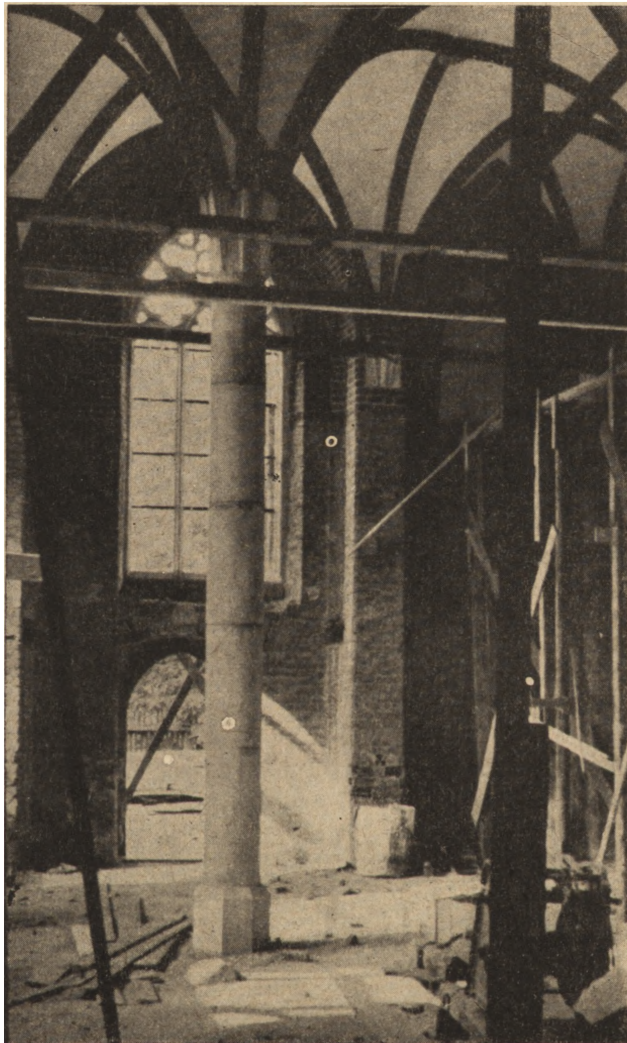
Ryc. 254. Widok nawy głównej ze zrekonstruowanym filarem podczas prac konserwatorskich.
