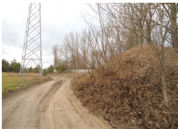
Fot. 3. Widok na Fort nr 4 od strony południowej (fot. E. Maślańska)
