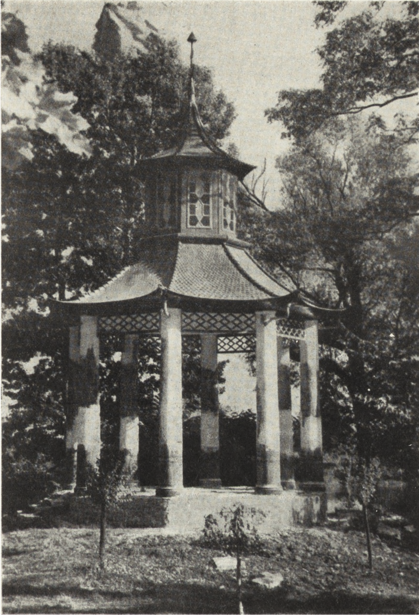
Ryc. 18. Altana chińska z Wilanowa po konserwacji. Dach z łuski blaszanej wykonany przez M. Jarnuszkiewicza.
