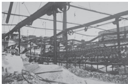
Wypalona hala tkalni – widok od południa; widoczne wały transmisyjne, które przenosiły napęd od maszyny parowej do krosien. Zdjęcie A. Stuglika z AP Oświęcim.
