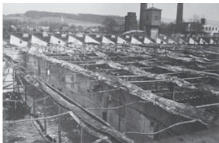
Widok od zachodu na całkowicie wypaloną halę tkalni; w głębi charakterystyczny shedowy dach wykańczalni. Zdjęcie A. Stuglika z AP Oświęcim.
