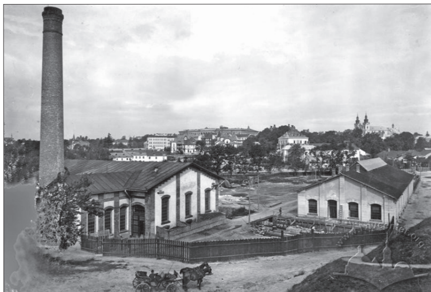
Pierwsza elektrownia we Lwowie
