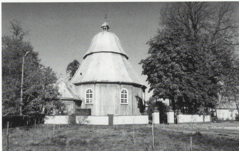
Wyszyna, kościół p.w. Narodzenia MP po konserwacji. Fot. T. Łuczak
