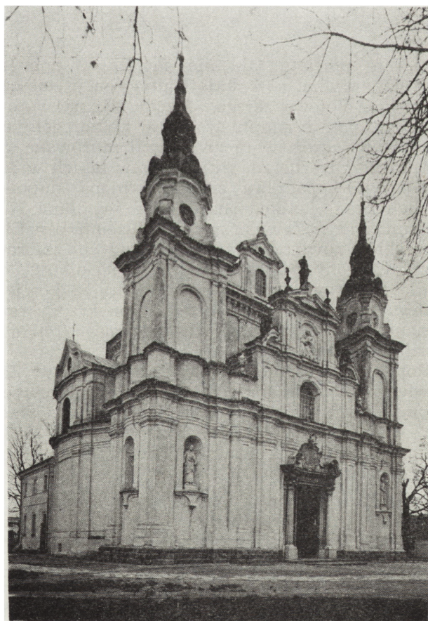
2. Lubartów, kościół parafialny Sw. Anny z lat 1733—1738 (architekt P. Fontana). Widok od północno-zachodu, stan z 1972 r. (Fot. J. Langda, ze zb. IS PAN)
