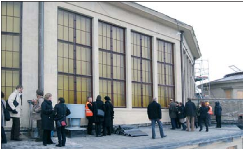
1. Oględziny prac konserwatorskich przy Hali Stulecia we Wrocławiu. Wszystkie fot. J. Lewicki. 1. Examination of the conservation of the Centennial Hall in Wrocław. All photos: J. Lewicki.
