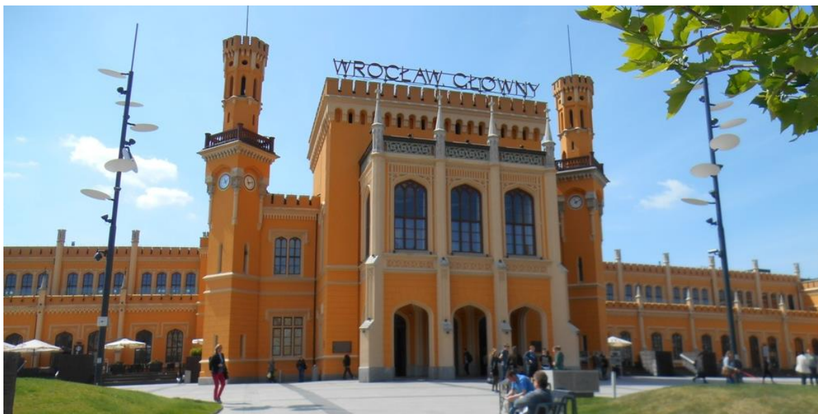
Ryc. 4. Dworzec kolejowy we Wrocławiu
