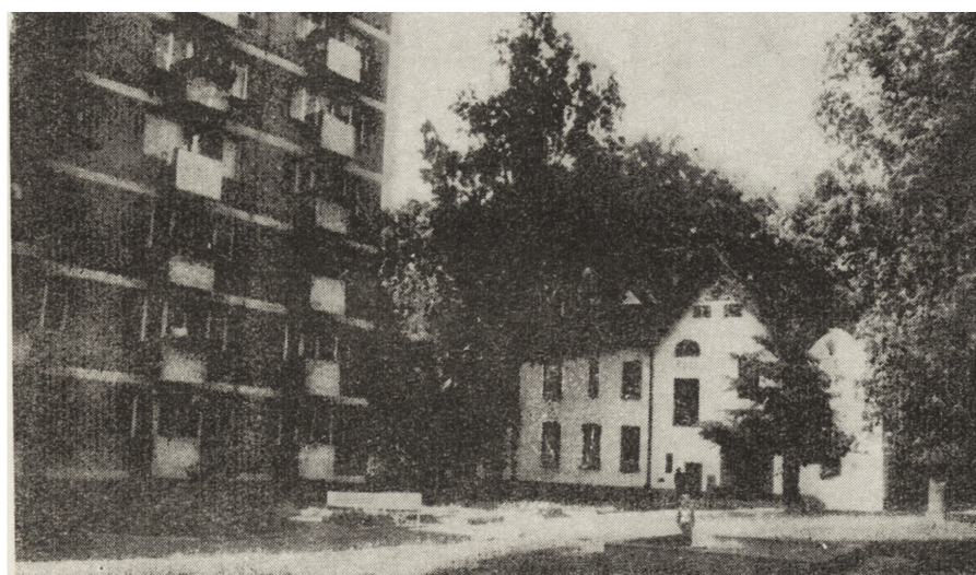
8. Sopot, jedenastokondygnacyjny blok mieszkalny w sąsiedztwie secesyjnej willi z 1903 r. (ul. Władysława IV nr 1) — naruszył unikatowe walory przestrzenno-kulturowe słynnej sopockiej skarpy, stan z 1976 r. (fot. J. Stankiewicz)
