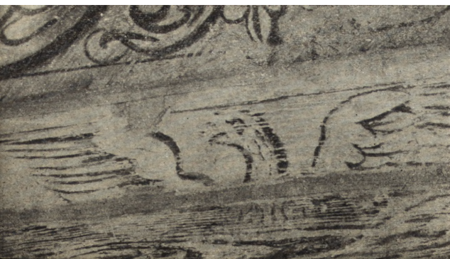
Ryc. 240. Fragment polichromii w wieży „Śniadeckiego” z w. XVIII, przed konserwacją.
