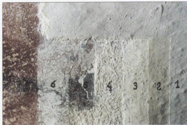
7. Układ jednobarwnych warstw farby oraz pobiał wapiennych pokrywających oryginalną polichromię – najmlodsze nawarstwienie (1) powstało przed 1939 r. Warstwa 5 stanowi pierwsze po pożarze przemalowanie nawiązujące do firmamentu
