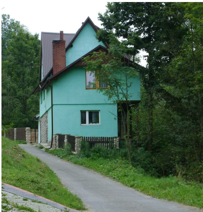
Ryc. 11. Budynek usytuowany w sąsiedztwie doliny wciosowej, dolina Potoku Lubańskiego, gmina Ochotnica Dolna (fot. M. Maślanka)
