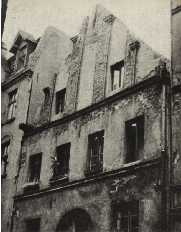
Ryc. 150. Toruń — szczyt kamienicy przy ul. Franciszkańskiej przed konserwacją.
