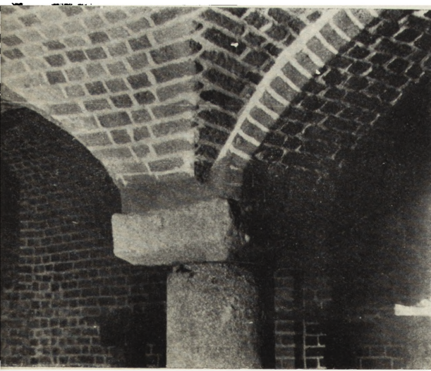
Ryc. 153—154. Toruń — podziemia Ratusza Staromiejskiego przed konserwacją i po przemurowaniu i wyfugowaniu.
