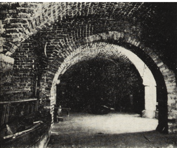
Ryc. 153—154. Toruń — podziemia Ratusza Staromiejskiego przed konserwacją i po przemurowaniu i wyfugowaniu.
