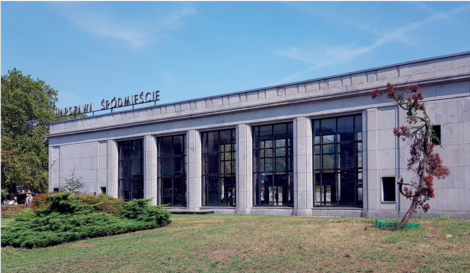
➤ Widok na jeden z pawilonów wejściowych Dworca Warszawa Śródmieście, arch. A. Romanowicz, P. Szymaniak 1955, zdjęcie: A. Sumorok, 2019
