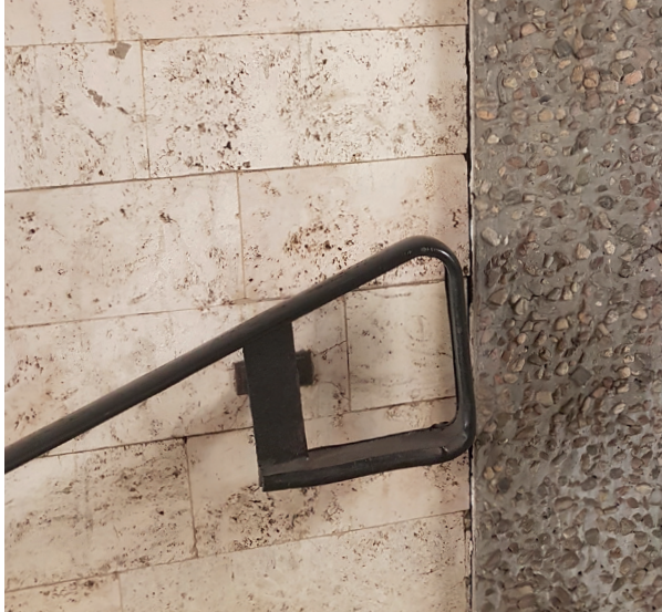
➤ Zestawienie materiałów na ścianach, połączenie trawertynu i płukanego betonu, zdjęcie: A. Sumorok, 2019
