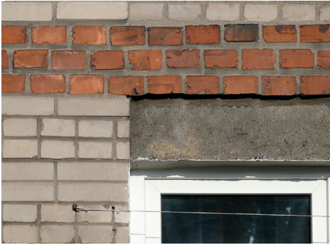
Bielany II, S. Żeromskiego 4 street – fragment of the original facade
