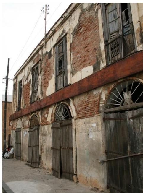
Ryc. 10. Saint-Louis. Przykłady zabudowy kolonialnej. Wyremontowany budynek w północnej części wyspy N'Dar (po lewej) oraz przykład walącego się budynku w południowej części tej samej wyspy (po prawej). Źródło: fot. Krzysztof Górny, 2016.
