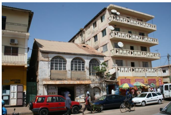
Ryc. 9d. Bandżul. Przykład zabudowy mieszanej znajdującej się w sąsiedztwie Albert Market. Obok niższego domu z czasów kolonialnych, o charakterystycznych szerokich oknach, częściowo niezamieszkałego, wybudowano nowy 4-piętrowy blok kontrastujący z okolicą (zapewne w miejscu, gdzie poprzednio stał inny budynek z czasów kolonialnych).
