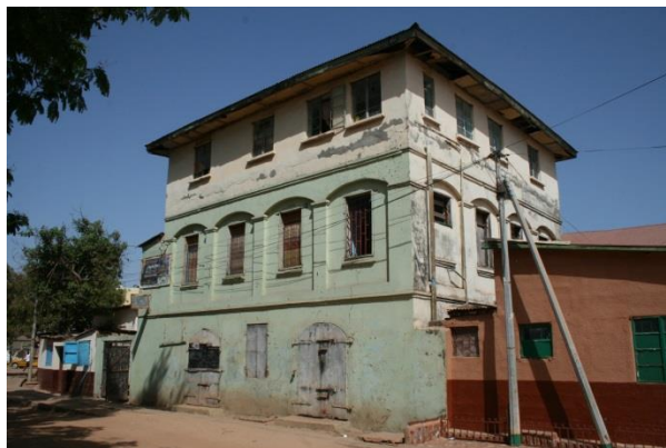
Ryc. 9b. Bandżul. Budynek pokolonialny, mieszkalny, murowany. Na parterze nie znajdują się żadne sklepy ani magazyny, natomiast piętra wyżej są użytkowane jako mieszkania.
