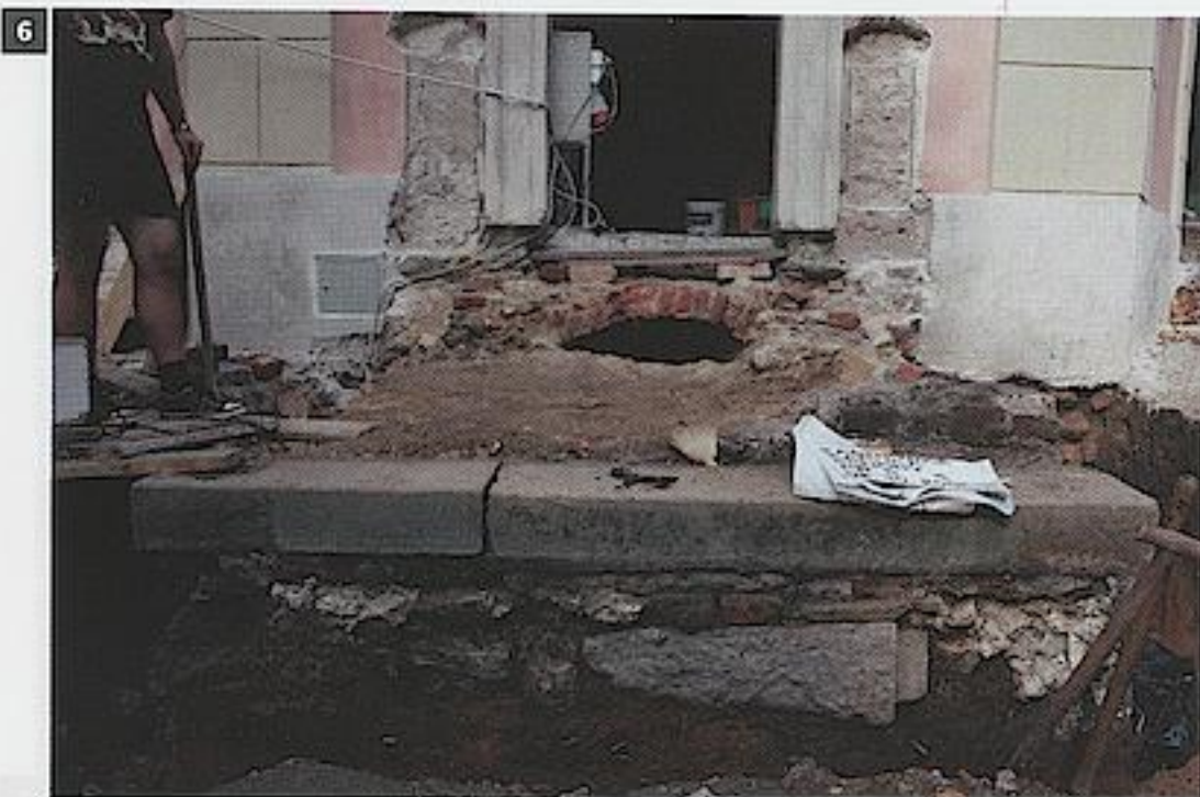
6. Karniowice, kaplica, portal po odstąpieniu wejścia do krypty, widoczne stopy węgarów pierwotnego portalu. Fot. Jerzy Kowalski
