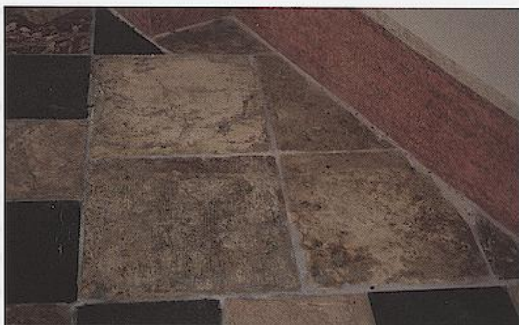
7. Karniowice, kaplica, rekonstrukcja pierwotnego pasa malowideł przy posadzce. Fot. Jerzy Ruciński
