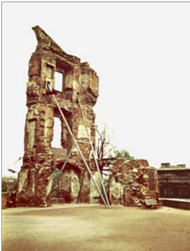
4. Warszawa. Fragment ruin zamku przed jego odbudową. Przykład tymczasowego (odwracalnego) zabezpieczenia konstrukcyjnego w formie podparcia ze stalowych rur. Fot. J. Tajchman.
