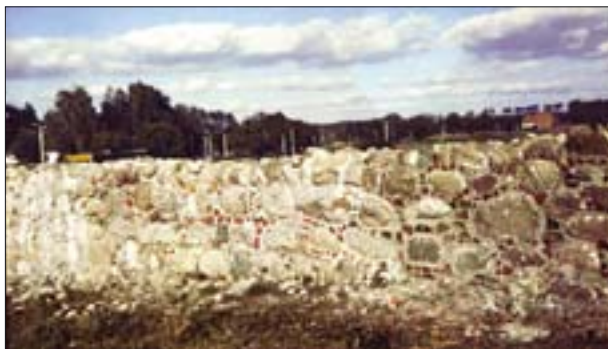
12. Wenecja k. Žnina. Ruina zamku. Poprawiona korona muru. Fot. J. Tajchman.
