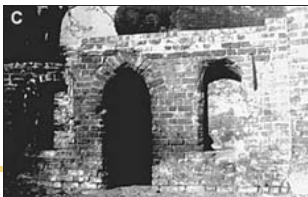
21. Toruń. Ruiny zamku. Fragment fotograficzno-rysunkowej dokumentacji metody zabezpieczenia korony i lica muru, oprac. J. Tajchman: A – stan przed podjęciem prac, B – projekt z zaznaczonym nadmurowaniem korony, izolacją (linia przerywana) oraz uzupełnieniami w licu, C – stan po przeprowadzeniu prac (uzupełnienia w licu zminimalizowane). Fot. J. Tajchman.
