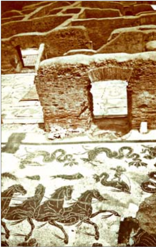
15. Ostia Antica w pobliżu Rzymu. Korona murów zabezpieczona zaprawą na bazie cementu puzzolanowego. Fot. J. Tajchman. 15. Ostia Antica near Rome. Wall coping protected with mortar based on puzzolan cement. Photo: J. Tajchman.
