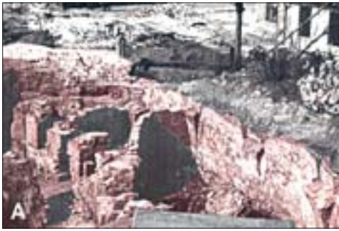
32. Toruń. Ruiny zamku krzyżackiego. A – malowniczy fragment murów przed zabezpieczeniem korony, 1964 r. Fot. J. Tajchman; B – ten sam fragment murów po pracach. Przykład usztywnienia korony mimo dążenia do jak najmniejszej ingerencji w substancję zabytkową. Po latach malowniczość obiektu poprawiła samorodna zieleń, 2003 r. Fot. E. Okoń.
