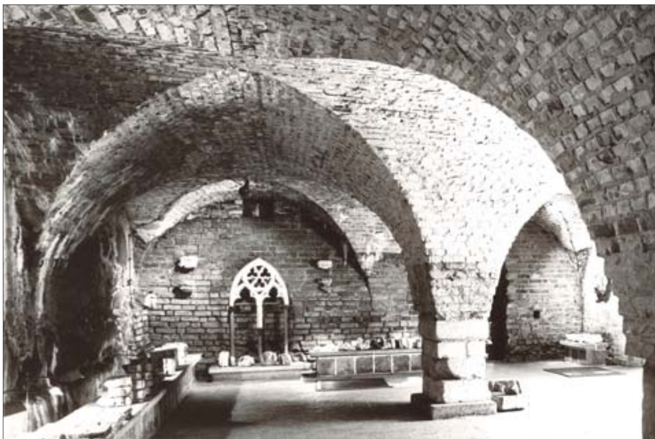
7. Toruń. Ruiny zamku po pracach w 1966 r. Piwnice adaptowane na lapidarium po rekonstrukcji sklepień ze względów statycznych i problemów z odwodnieniem. Rekonstrukcja czytelna przez zastosowanie współczesnej cegły, a jednocześnie zsynchronizowana z autentycznymi fragmentami nad słupami dzięki wykonaniu w dawnej technice na tzw. wycisk. Proj. aranżacji lapidarium E. Gąsiorowski. Fot. J. Wardak. 7. Toruń. Castle ruins after work conducted in 1966. Cellars adapted for a lapidarium after a reconstruction of the ceilings for static reasons and problems with drainage. Reconstruction legible due to the use of contemporary brick, synchronised with authentic fragments above the pillars thanks to the application of an old technique. Project of the lapidarium arrangement: E. Gąsiorowski. Photo: J. Wardak.
