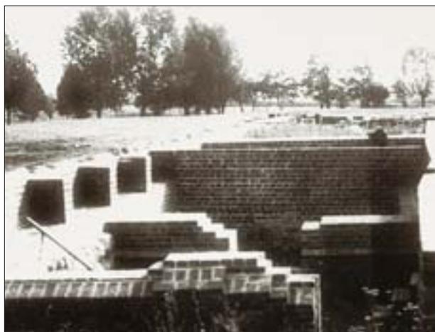
20. Chęciny. Negatywny przykład ruin odbudowanych z nowej cegły, która zasłania autentyczną substancję. Całość sprawia wrażenie nowych murów piwnicznych, a nie ruin. Fot. ze zbiorów IZK UMK.
