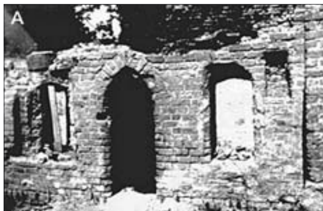
21. Toruń. Ruiny zamku. Fragment fotograficzno-rysunkowej dokumentacji metody zabezpieczenia korony i lica muru, oprac. J. Tajchman: A – stan przed podjęciem prac, B – projekt z zaznaczonym nadmurowaniem korony, izolacją (linia przerywana) oraz uzupełnieniami w licu, C – stan po przeprowadzeniu prac (uzupełnienia w licu zminimalizowane). Fot. J. Tajchman.
