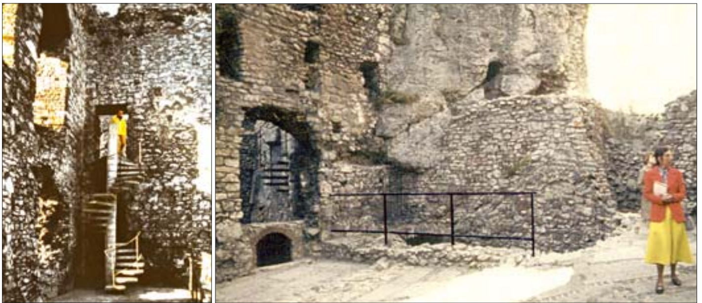
28. Ogrodzieniec. Ruiny zamku. Nowe schody na piętro ruin (zgodnie z projektowaną trasą zwiedzania). Współczesna konstrukcja z żelbetowych prefabrykowanych stopni wspornikowych, dzięki ażurowi i minimalnej barierze właściwie współgra z zabytkowymi ruinami. Fot. J. Salm.
