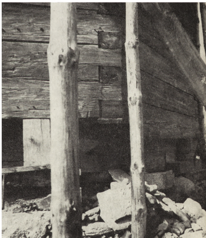
9. Haczów, dawny kościół par., fragment prezbiterium, stan z r. 1969 po usunięciu podwalin, przed wykopaniem fundamentów (fot. R. Brykowski)
