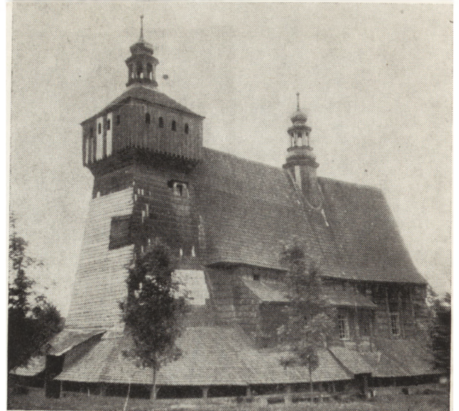
4. Haczów, dawny kościół par., widok od płd.-zach.; stan po prowizorycznych zabezpieczeniach w r. 1956 (fot. R. Brykowski)
