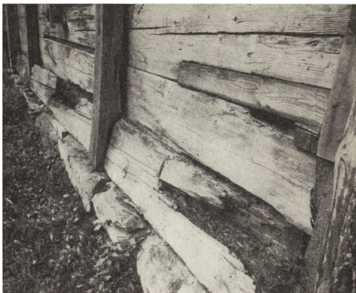
8. Haczów, podwaliny prezbiterium od pld., stan z r. 1962 (fot. J. Langda, zbiory IS PAN)
