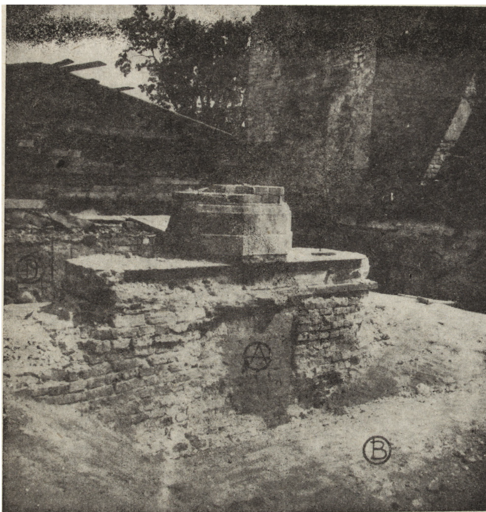
5. Sala o Dwóch Słupach: A – fundament słupa północnego; B – wierzch sklepienia piwnicy; C – wschodni mur Domu Dużego; D – relikty ściany Domu Dużego pomiędzy salami o Dwóch i Trzech Słupach; E – miejsce wejścia do schodów w grubości muru (por. fot. 2) 1960 r.
