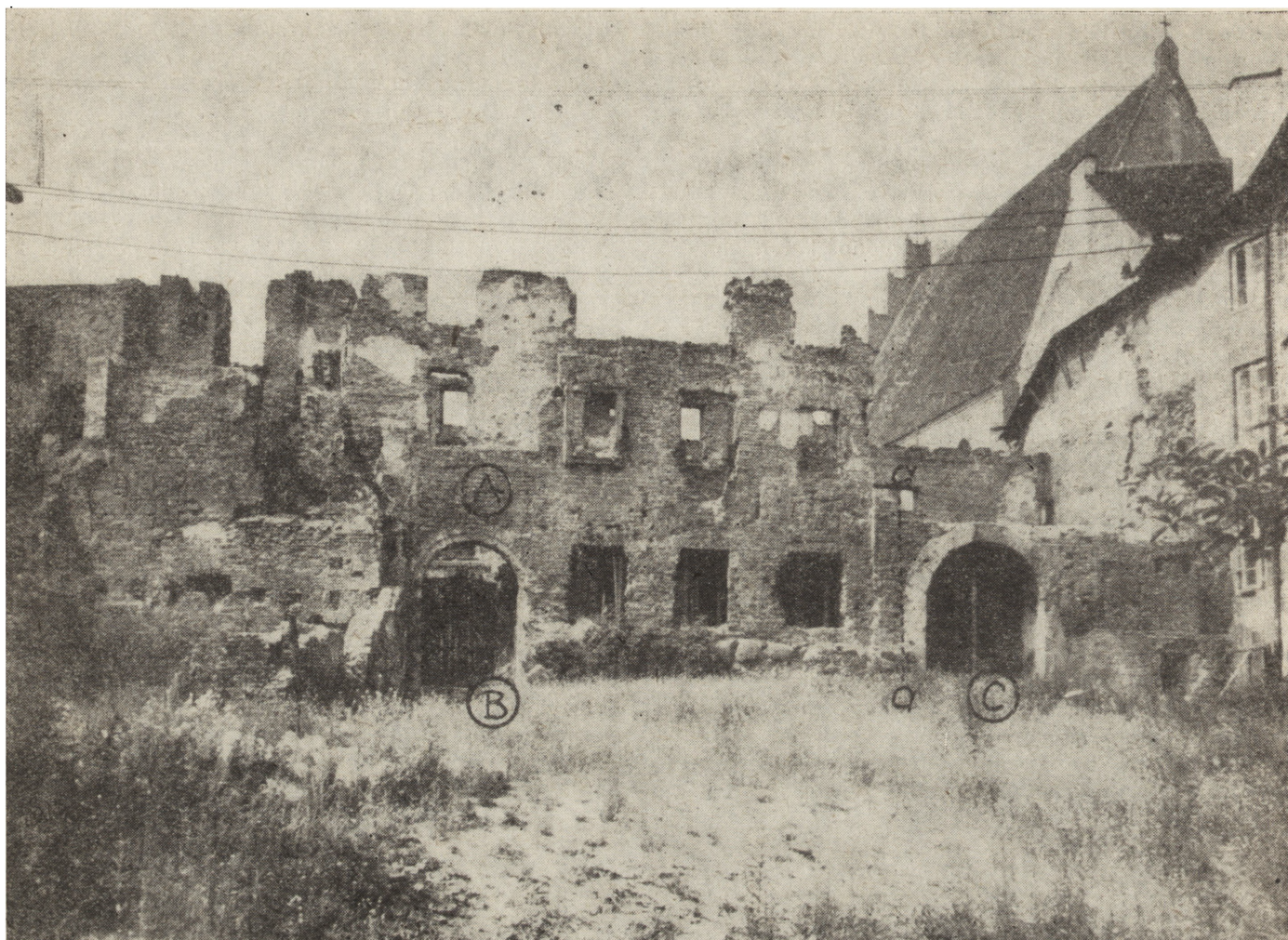
3. Zabudowa uliczki prowadzącej do Kanonii (Curia Minor), elewacja od strony Wisły: A – mur obronny z II połowy XIV w.; B – przejście z XVII w., zamurowane w 1818 r., obecnie odtworzone; C – przejście wykonane po 1925 r.; a-a – linia uskoku muru obronnego, 1961 r.
