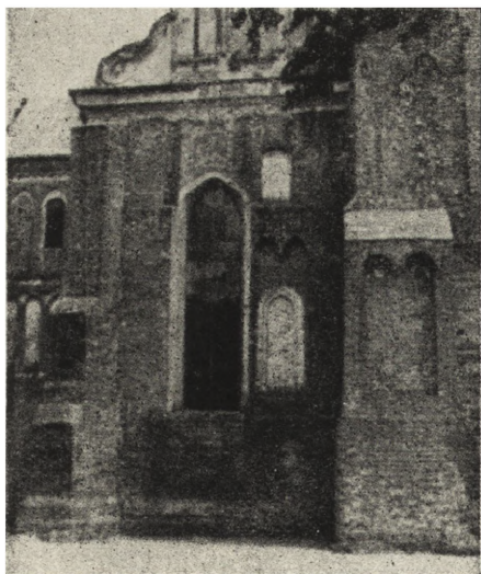
Ryc. 203. Fragment fasady zachodniej przed robotami konserwatorskimi.
