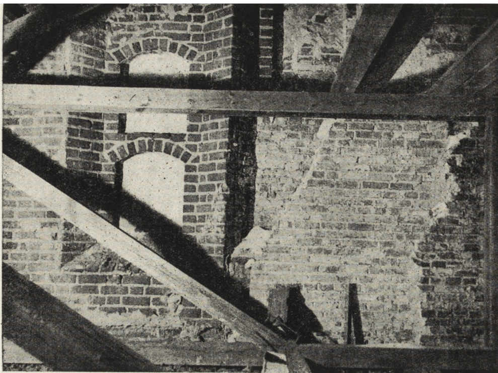
Ryc. 216. Fragment zachowanych dekoracji szczytu nawy bocznej przy łuku tęczowym, zabudowanych przez nową zakrystię.
