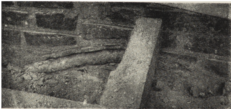
Ryc. 210. Odkryty w czasie badań muru fragment dawnego portalu — widoczny walek z cegieł profilowanych.
