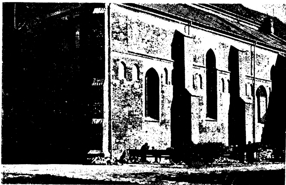
Ryc. 205. Fragment fasady południowej po pracach konserwatorskich (1955).
