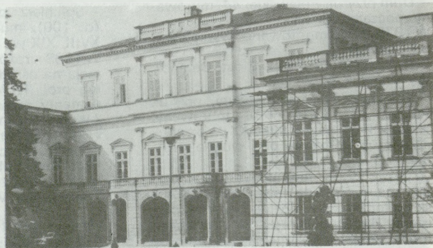
16. Puławy – pałac Czartoryskich, korpus główny, stan w trakcie prac konserwatorskich (fot. J. Żurawski, 1981)
