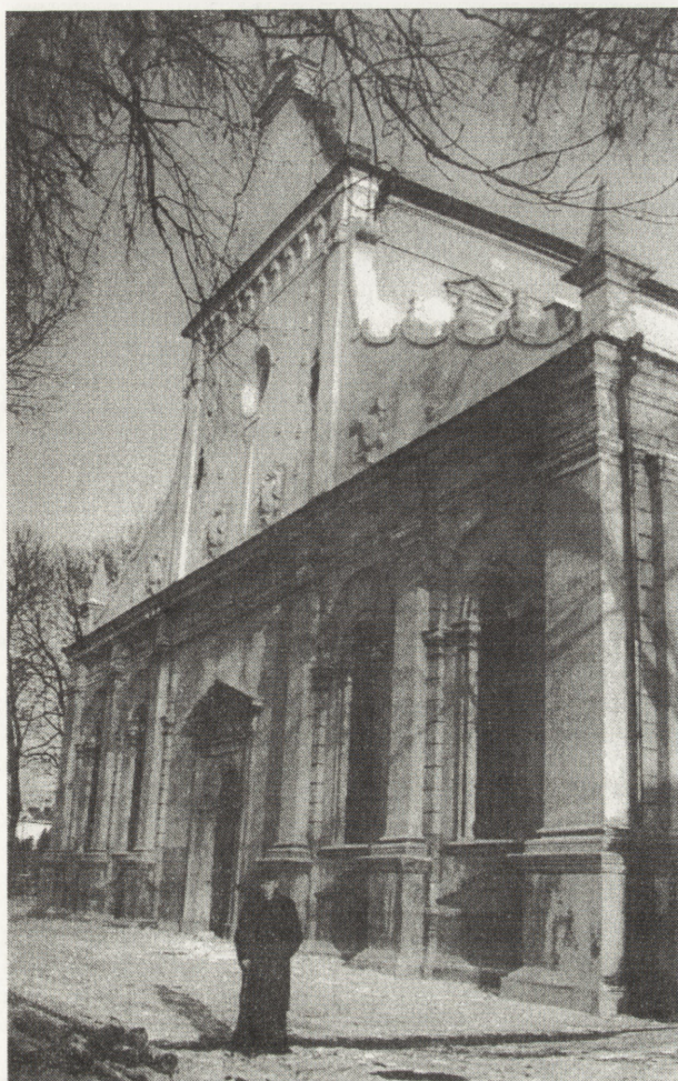
22. Górna część fasady kolegiaty po rekonstrukcji w latach 1990-91, proj. arch. T. Michalaka. Fot. J. Kowalczyk
