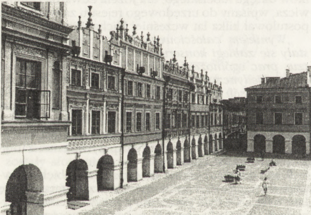
13. Kamienice w pierzei północnej Rynku Wielkiego, ul. Ormiańska 22-30, attyki zrekonstruowane w latach 1979-80, proj. architekti: W. Zin, A. Kadluczka i M. Pawlicki, Fot. CAF 13. Northern row of houses in the Great Market, 22-30 Ormiańska Street, attics reconstructed in 1979-80, project by W. Zin, A. Kadluczka and M. Pawlicki. Photo: CAF
