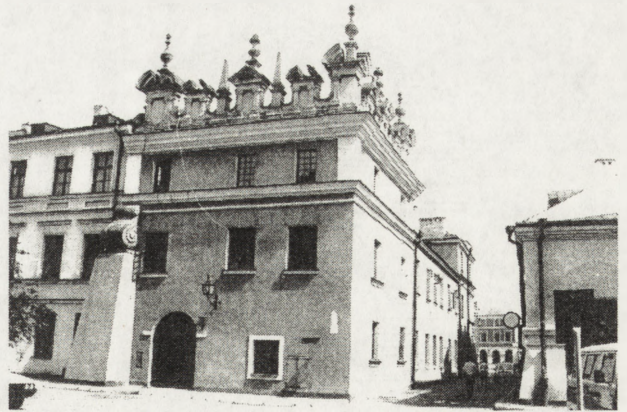
15. Kamienica przy ul. Kolegiackiej, attyka i skarpa zrekonstruowane w 1978 r. wg rysunku E. Andriollego, proj. arch. H. Kossuth i arch. G. Zamoyski, fot. J. Kowalczyk
