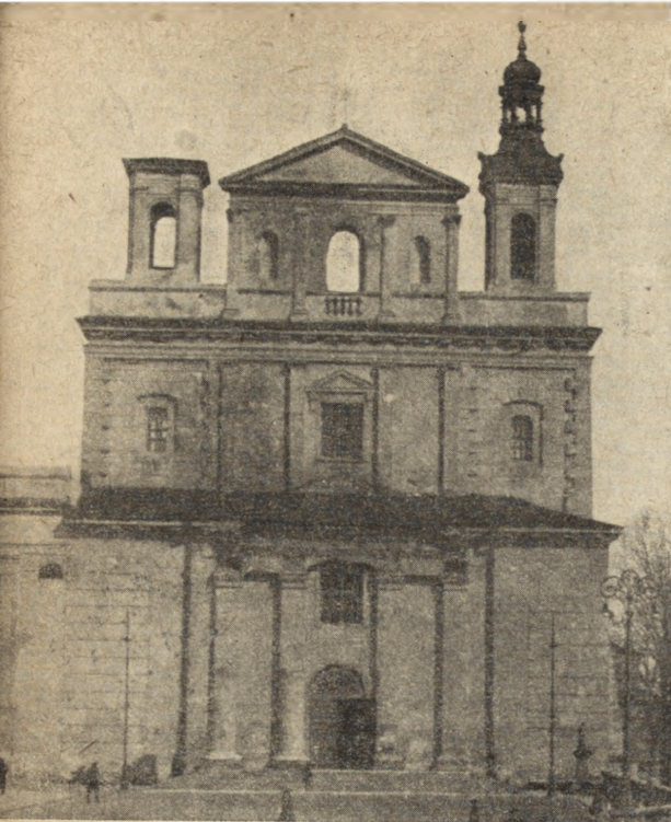
Ryc. 216. Katedra. Stan przed konserwacją.
