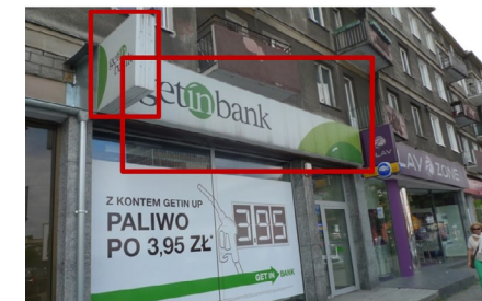
Ilustracja 20. Szyld równoległy i prostopadły do lica budynku (źródło: BRG)
