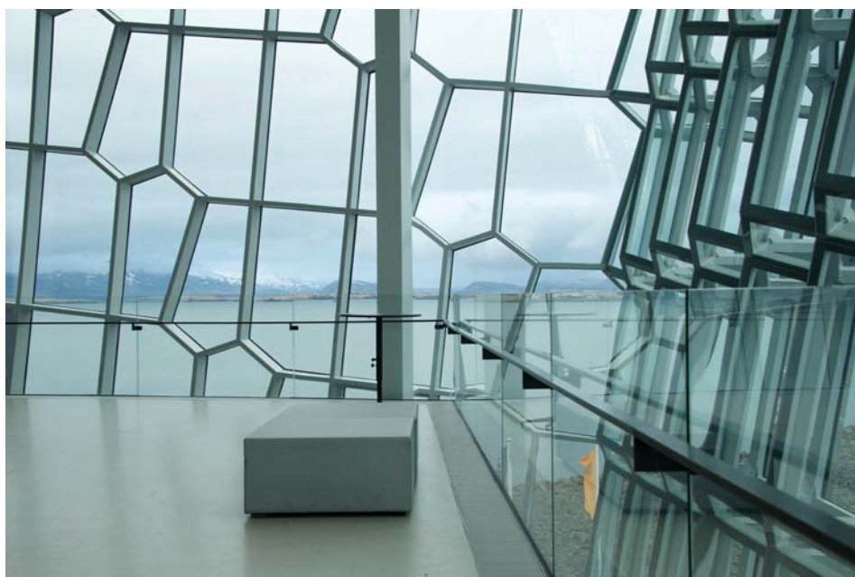
Il. 11. Harpa. Przejrzystość elewacji dzięki zastosowaniu antyrefleksyjnego szkła laminowanego (fot. K.B.-P.)
