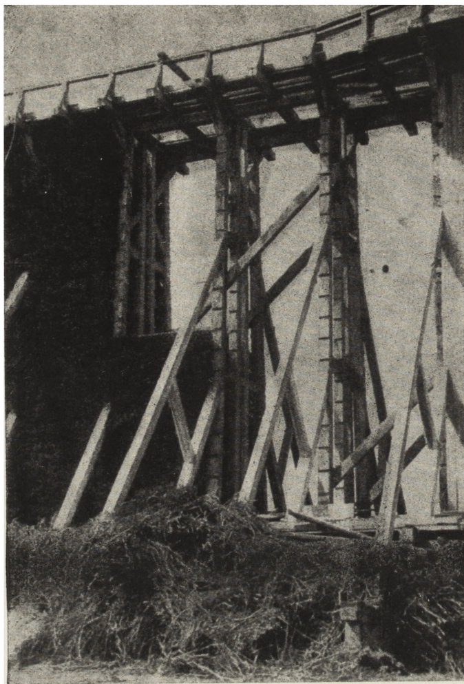
Ryc. 216. Tężnia nr 2 — szkielet konstrukcyjny.
