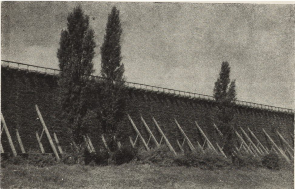
Ryc. 213. Ciechocinek, tężnia nr 1, widok faszyny cierniowej, wypełniającej szkielet konstrukcyjny.
